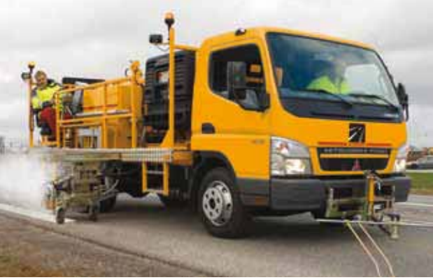
Termoplastik boya uygulaması için, kamyon üzerine monteli yol çizgi ekipmanı, termoplastik sprej uygulaması yaparken.
